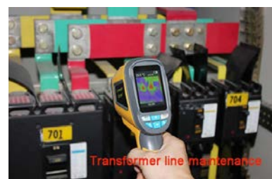
Transformer line maintenance Transformer line maintenance Mantenimiento de la línea del transformador
