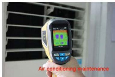
Air conditioning maintenance Air conditioning maintenance Mantenimiento del sistema de aire acondicionado
