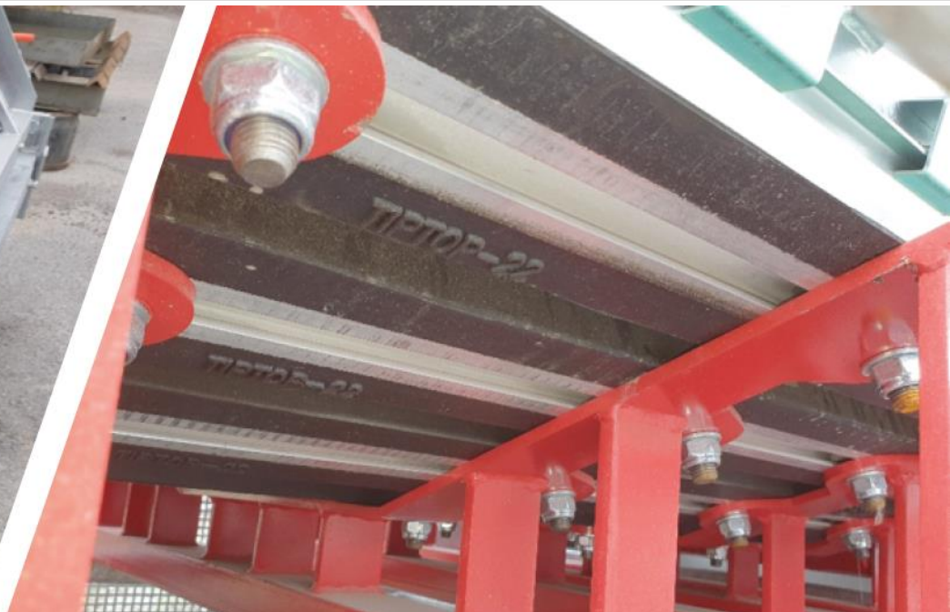
Вид снизу: алюминиевая шина с рекомендуемыми четырьмя креплениями
